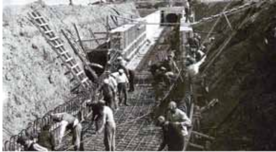
Neredeyse tamamı Türk mühendis ve işçileri tarafından yapılan 42 aylık inşaat ve montaj çalışmalarının ardından Ereğli Demir-Çelik Tesisleri 15 Mayıs 1965 günü işletmeye açılmıştır.
